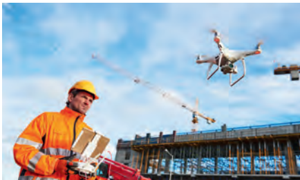
Verificarea cu drona a unei construcții
